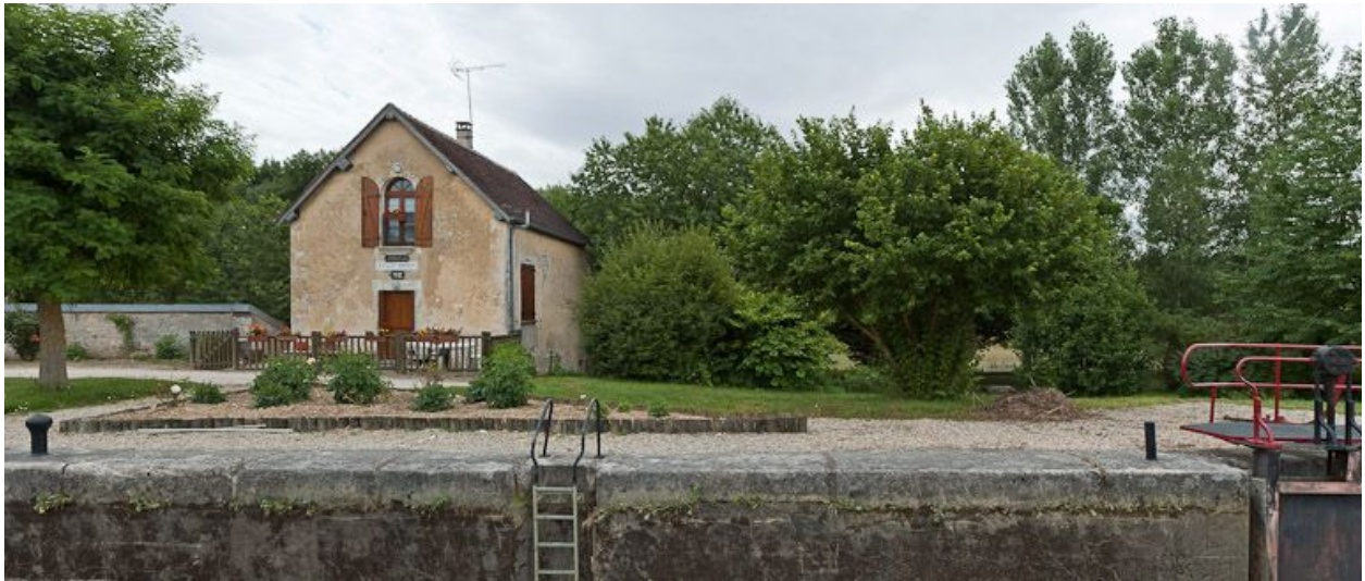
Vue de face de la maison éclusière.
