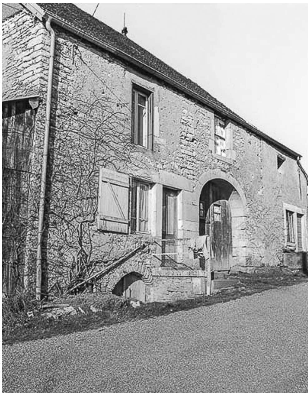
Façade antérieure partie gauche, habitation sur cave.
