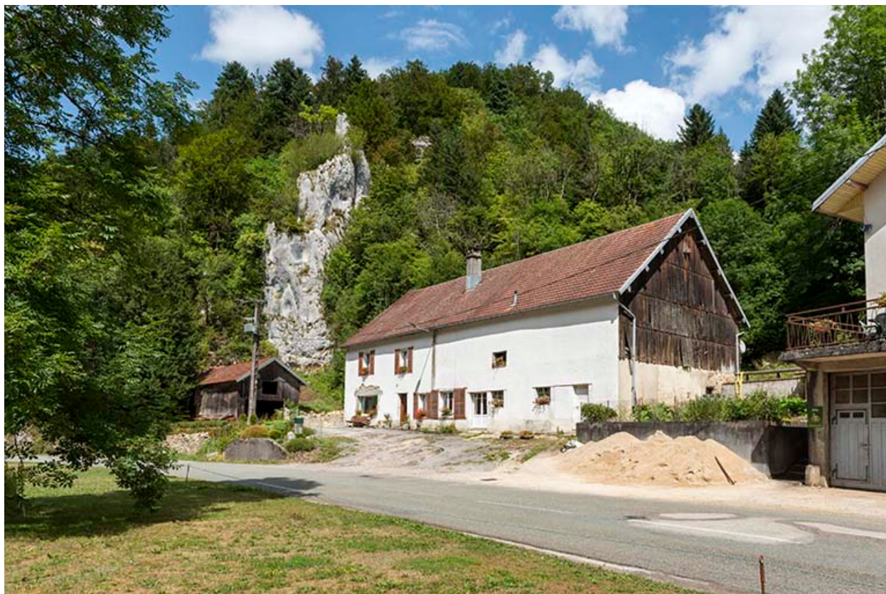
Logement (avec les anciennes grange et étable).
