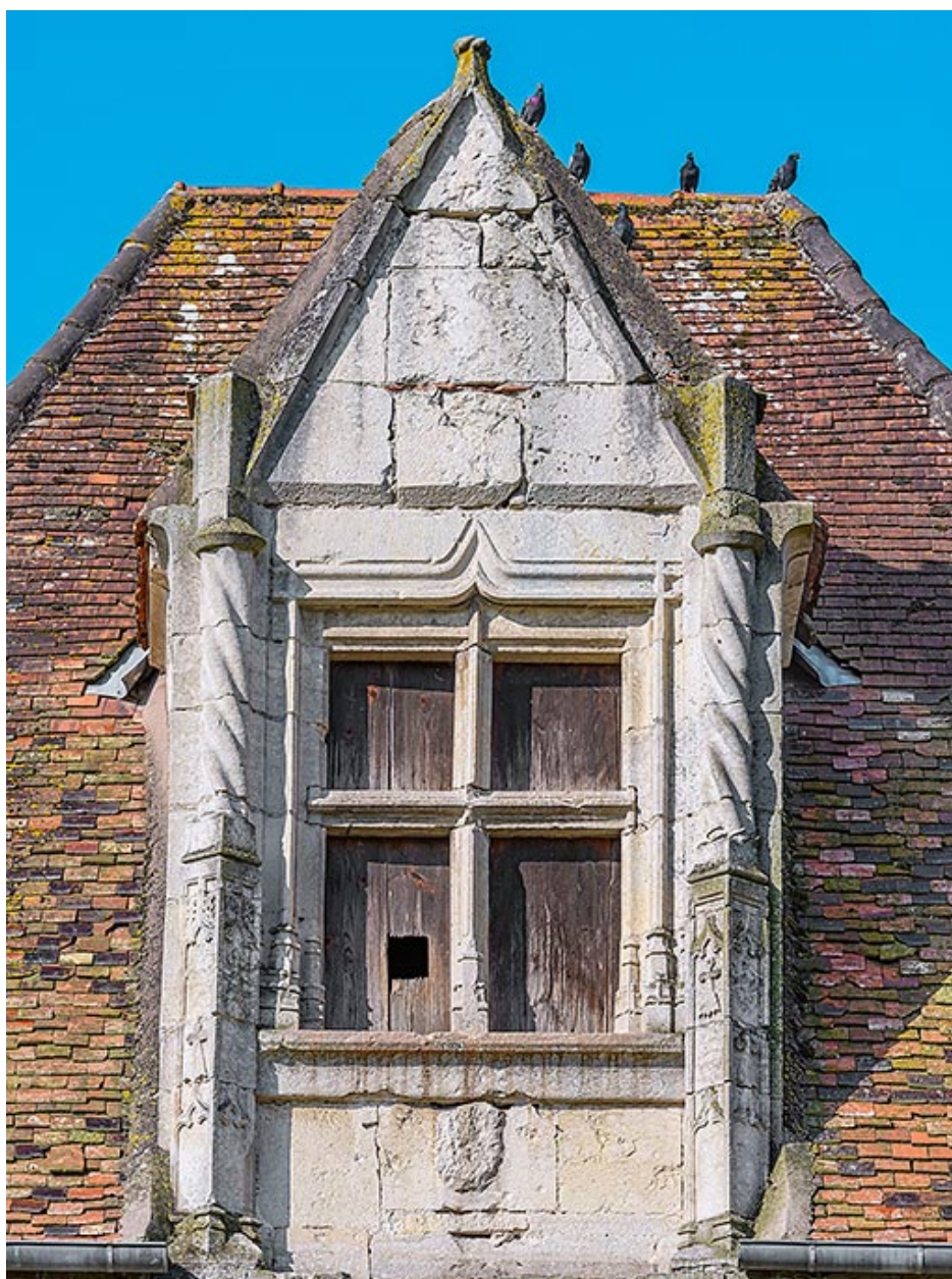
Vue de la baie à meneau.
