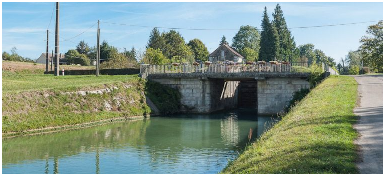
Le pont vu d'aval.
