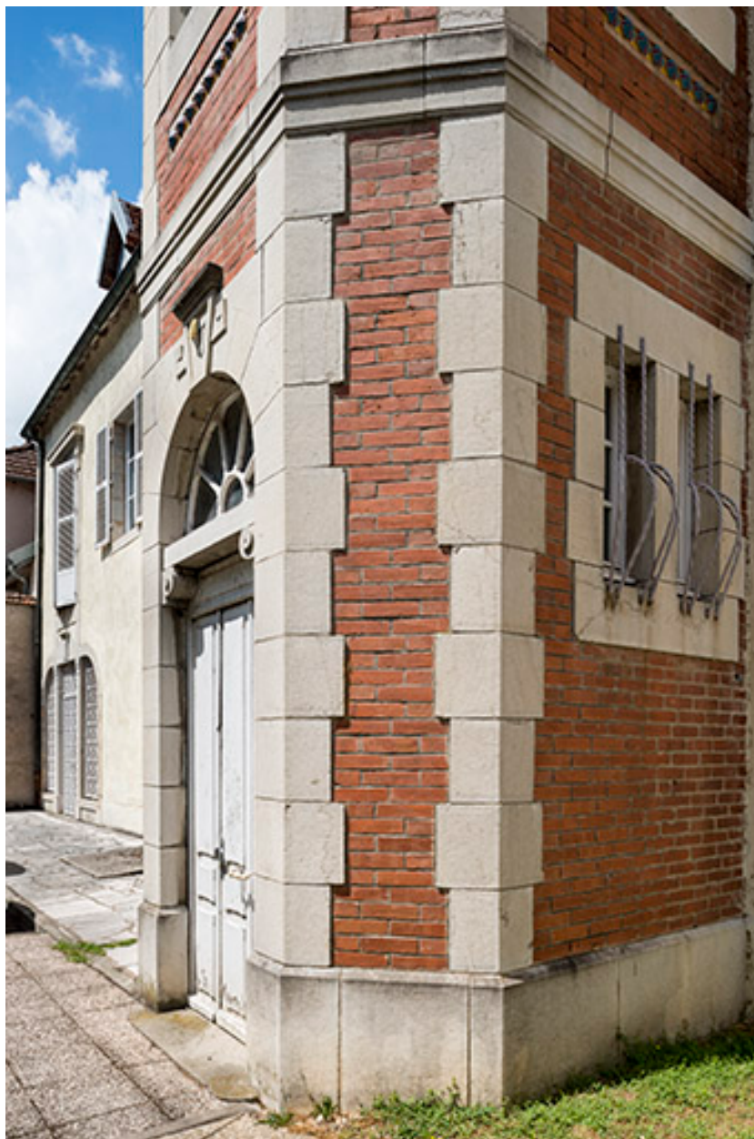
Base de la tourelle avec jeux de chainages en pierre de taille.
