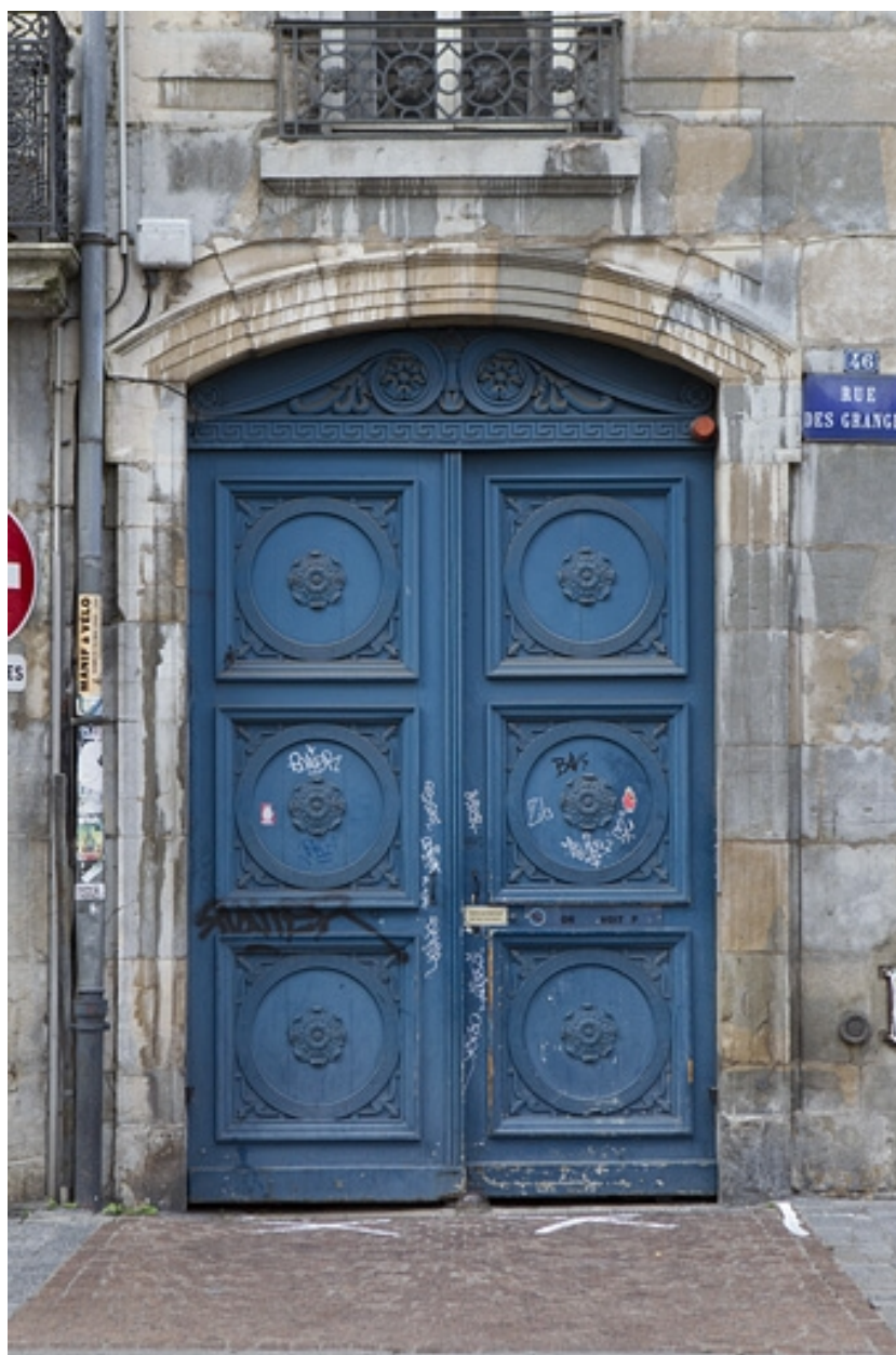
Vue d'ensemble du portail d'entrée.
