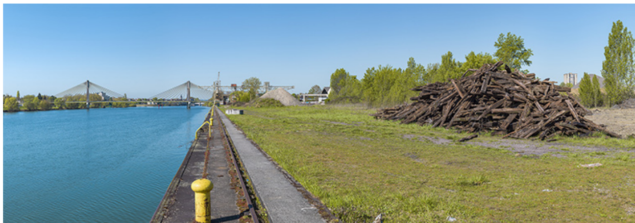
Le mur de quai.
