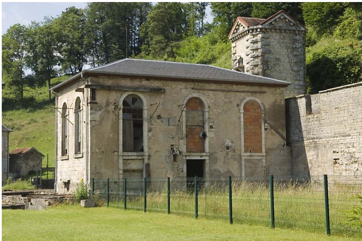
Façade ouest de la salle des machines.
