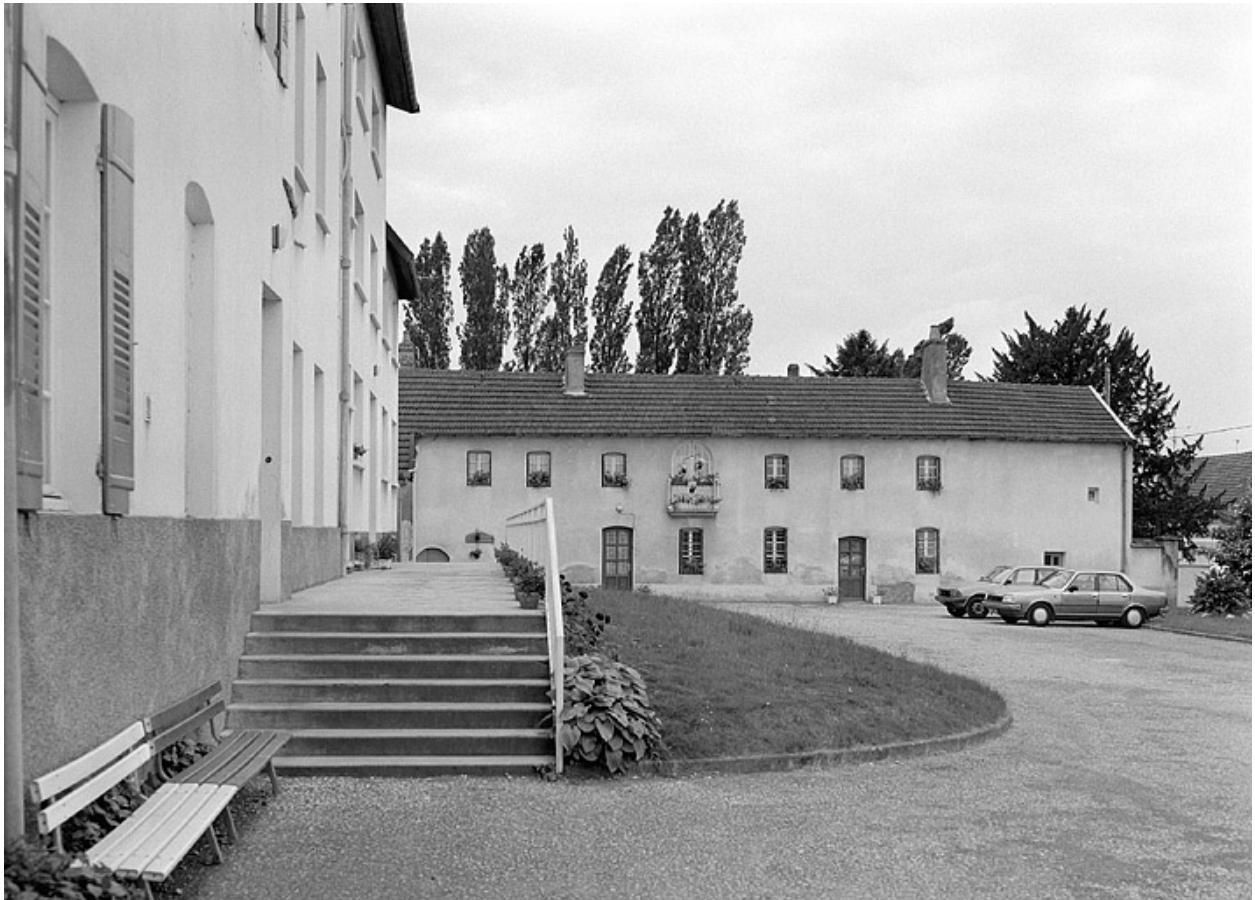
Vue d'ensemble du bâtiment droit.
