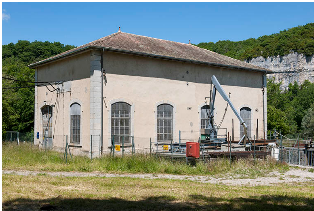
La centrale hydroélectrique vue de trois quarts.
