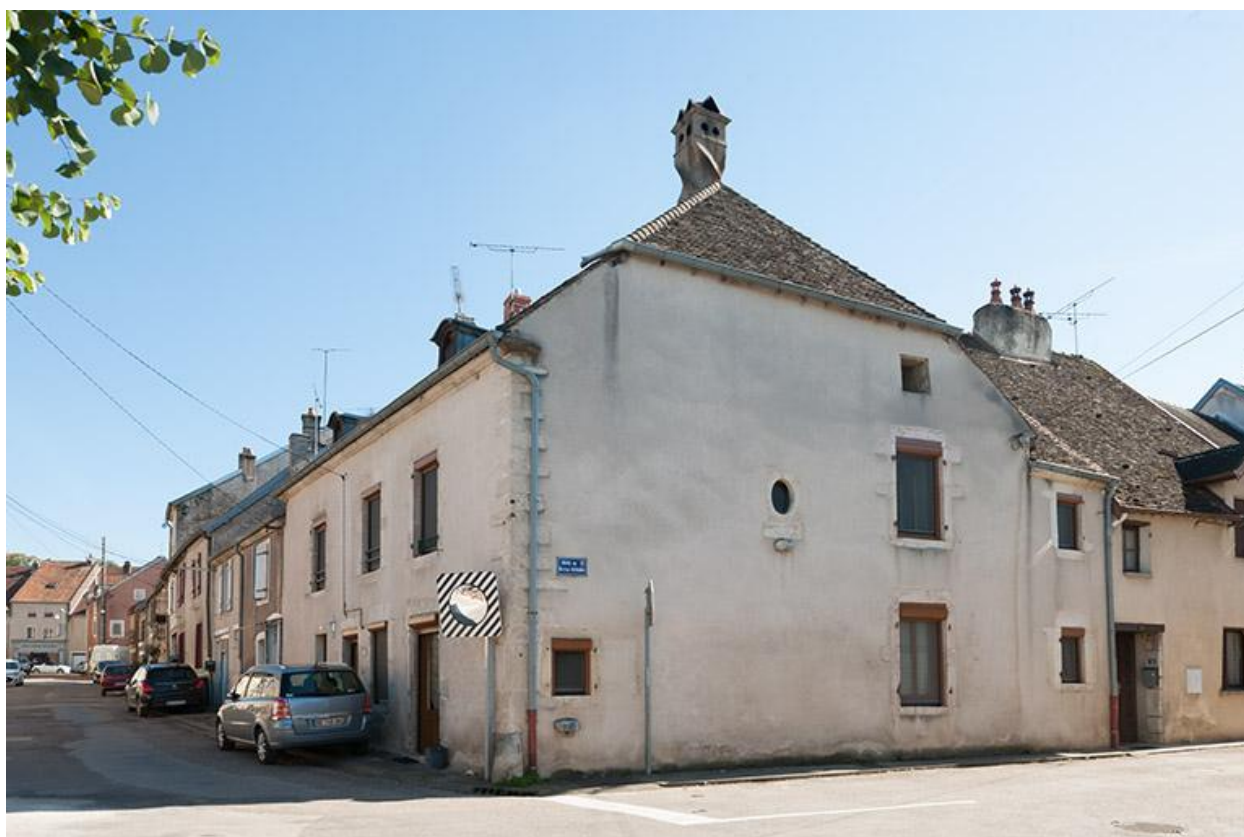
Maison située rue du 10 Septembre
