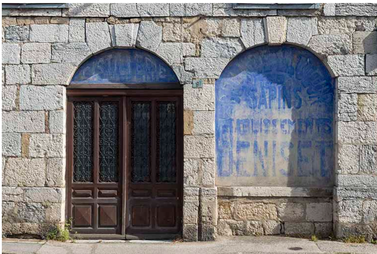
Détail de la façade ouest.
