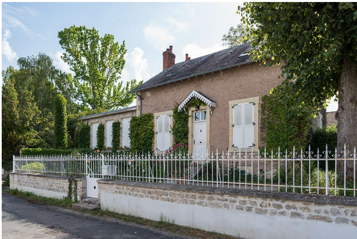
Vue de trois quarts depuis l'ouest.
