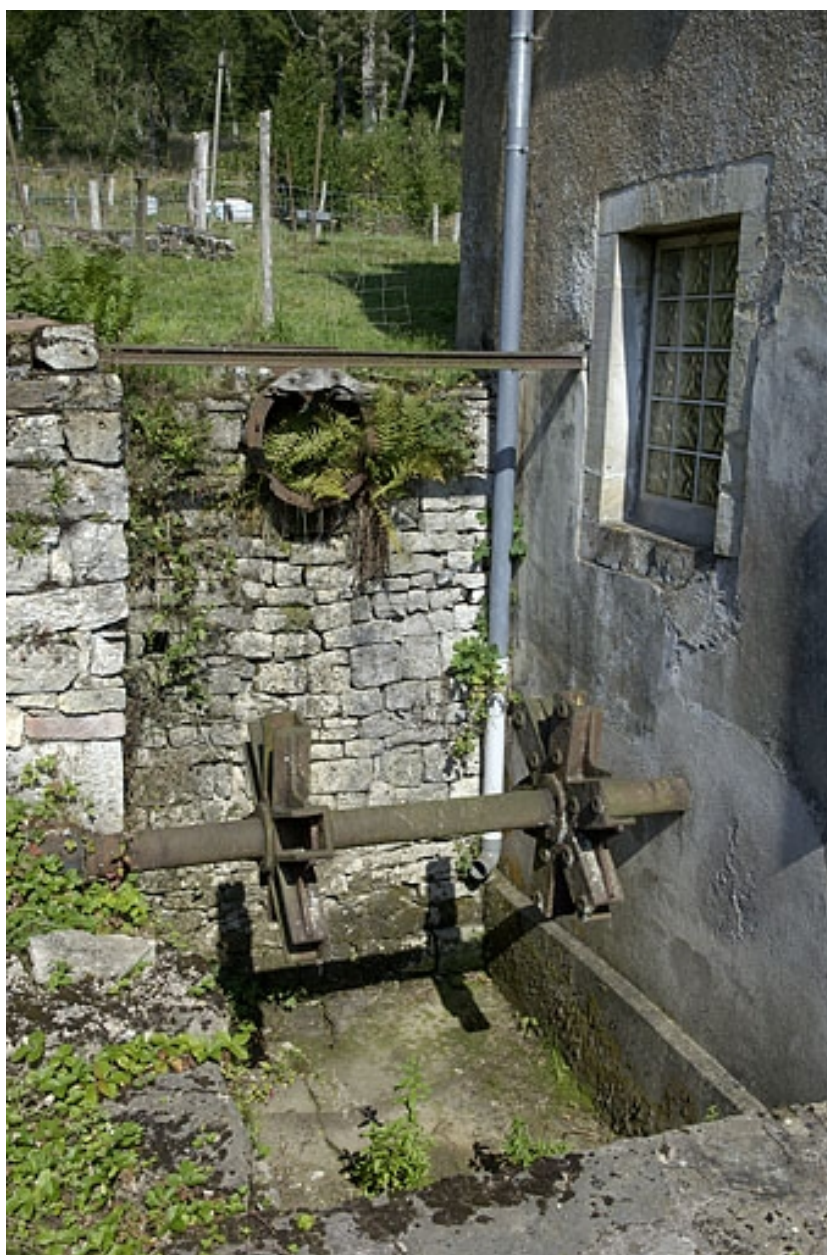
Emplacement de la roue hydraulique.
