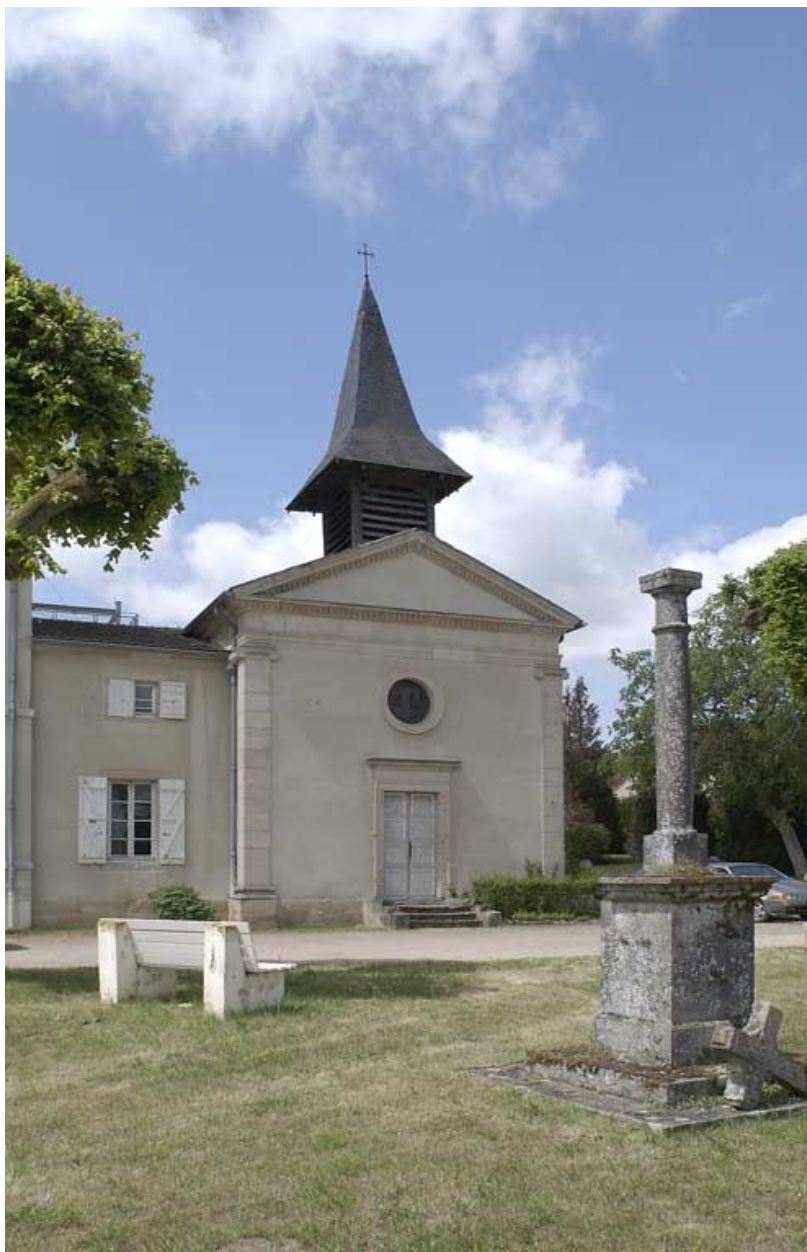
Façade antérieure de la chapelle et croix.
