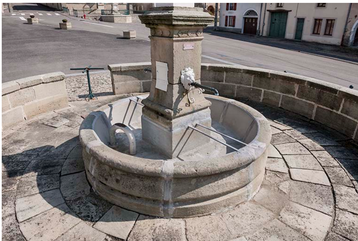
Intérieur de la fontaine.
