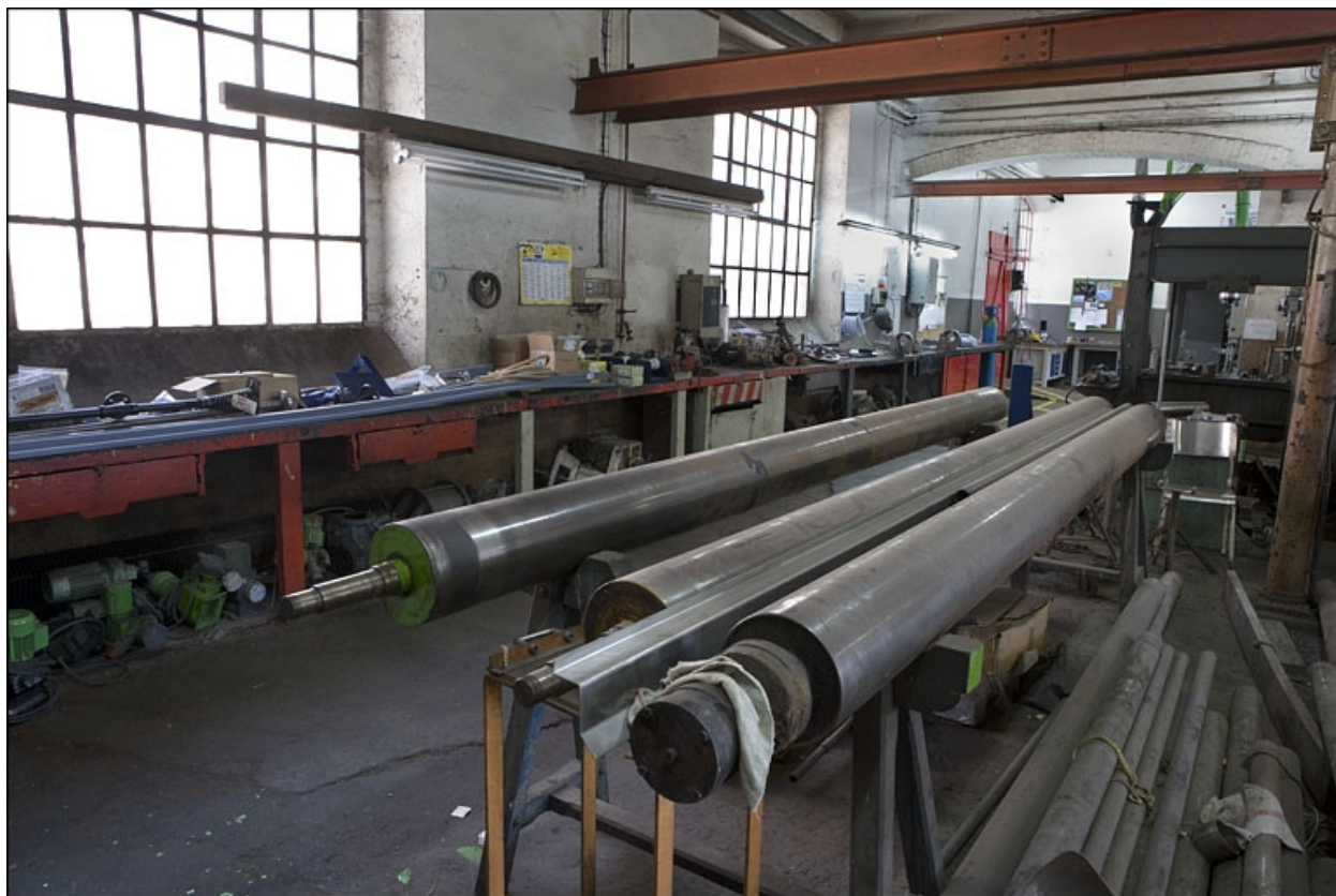
Atelier de réparation et de maintenance. Vue intérieure.
