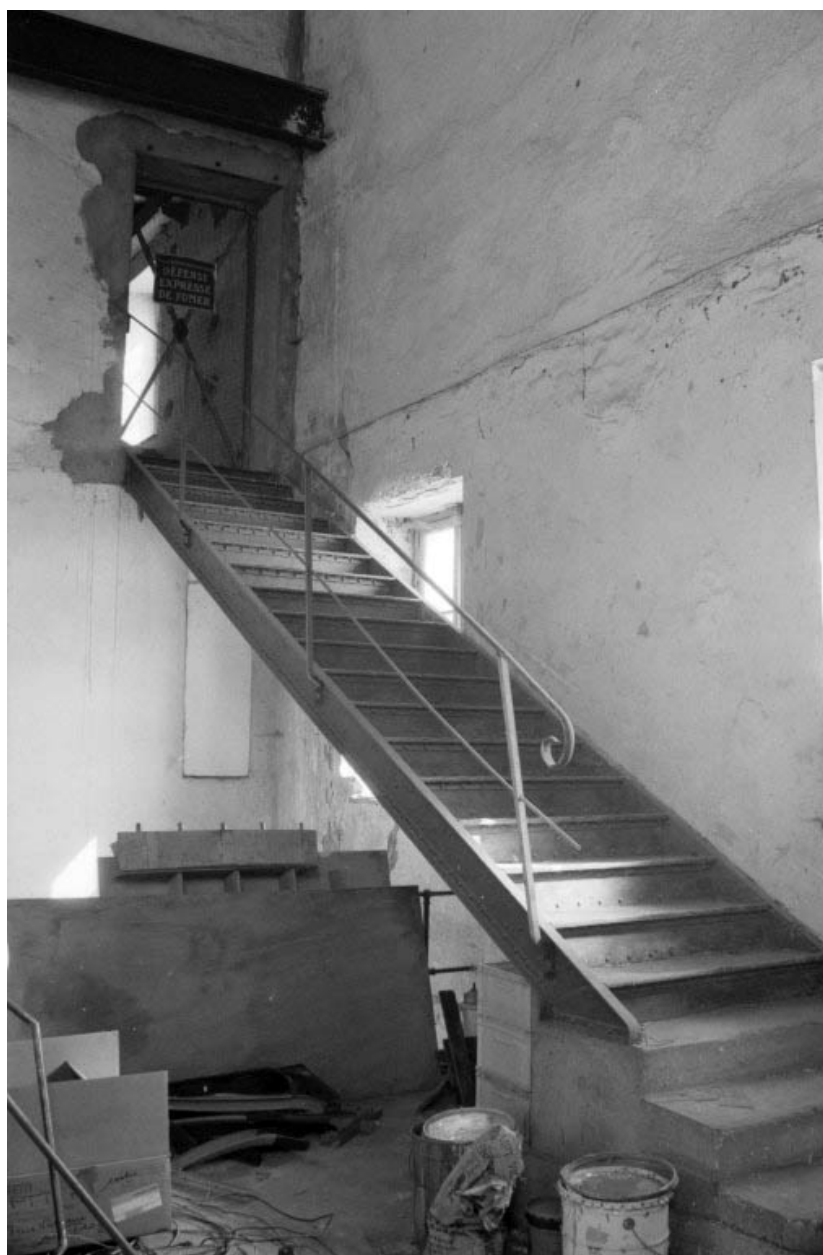
Salle des machines à vapeur (b3) : escalier.
