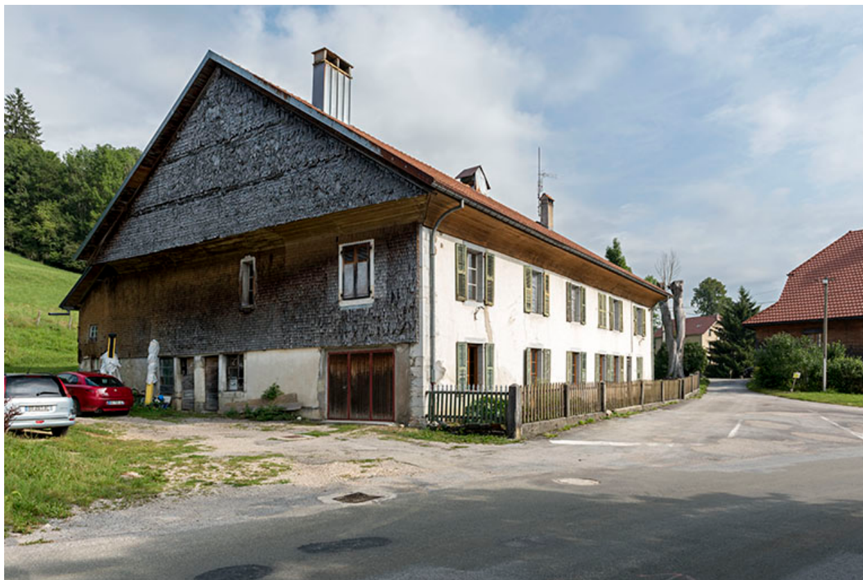
Façades antérieure et latérale gauche.
