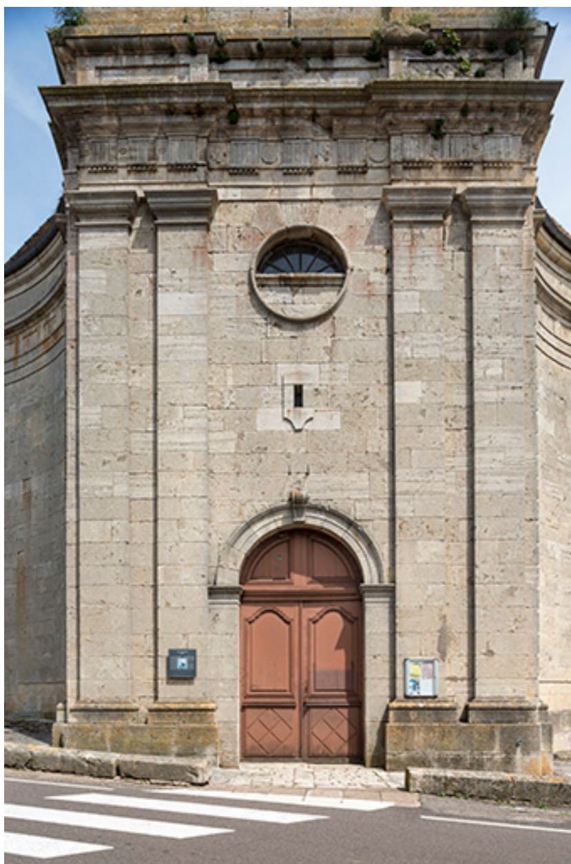
Clocher, premier niveau.
