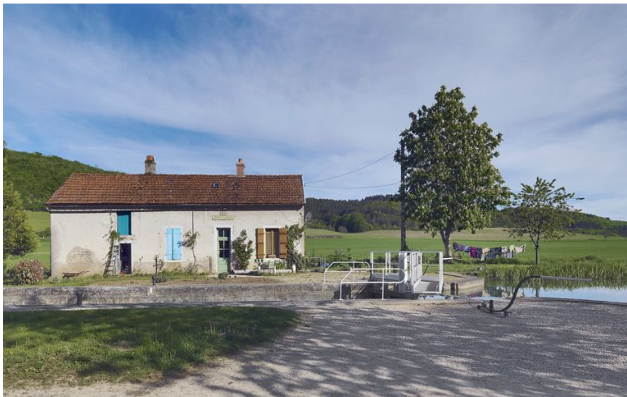
Maison éclésièrè de face.
