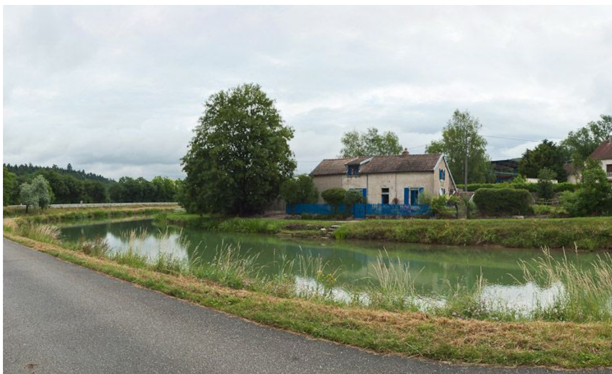
Vue de la maison de garde.
