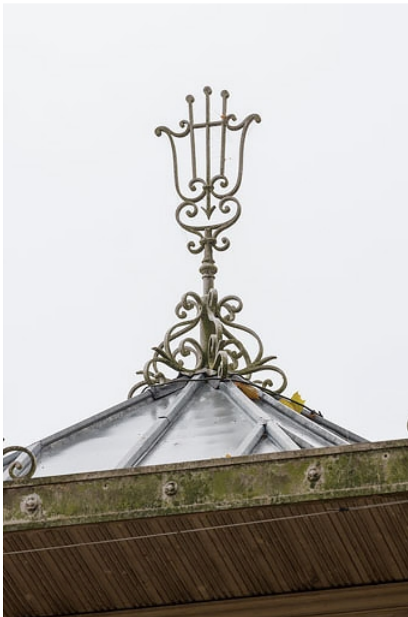
Epi de faitage en forme de lyre.
