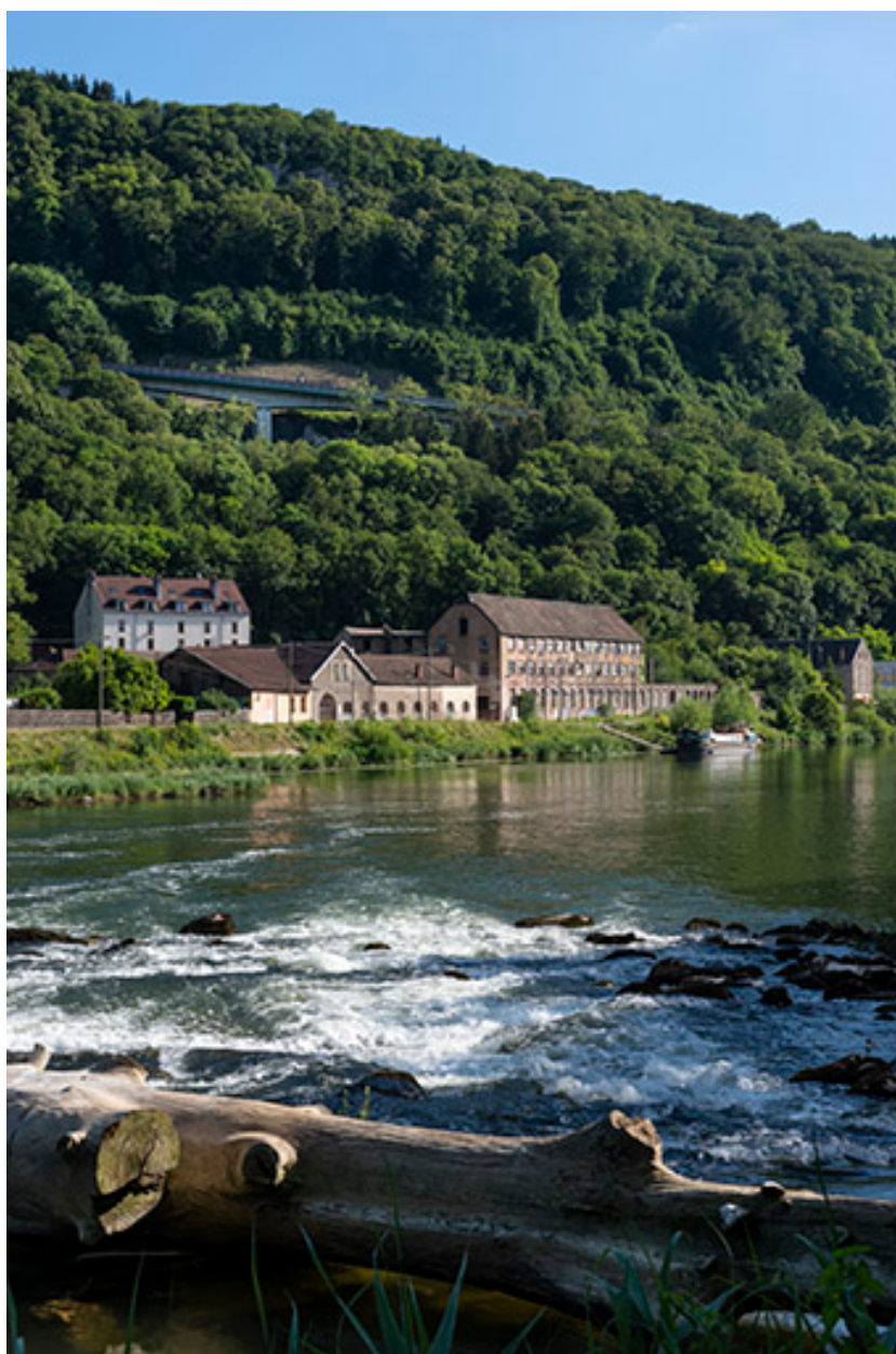
Vue d'ensemble depuis le nord-est (cadrage vertical).
