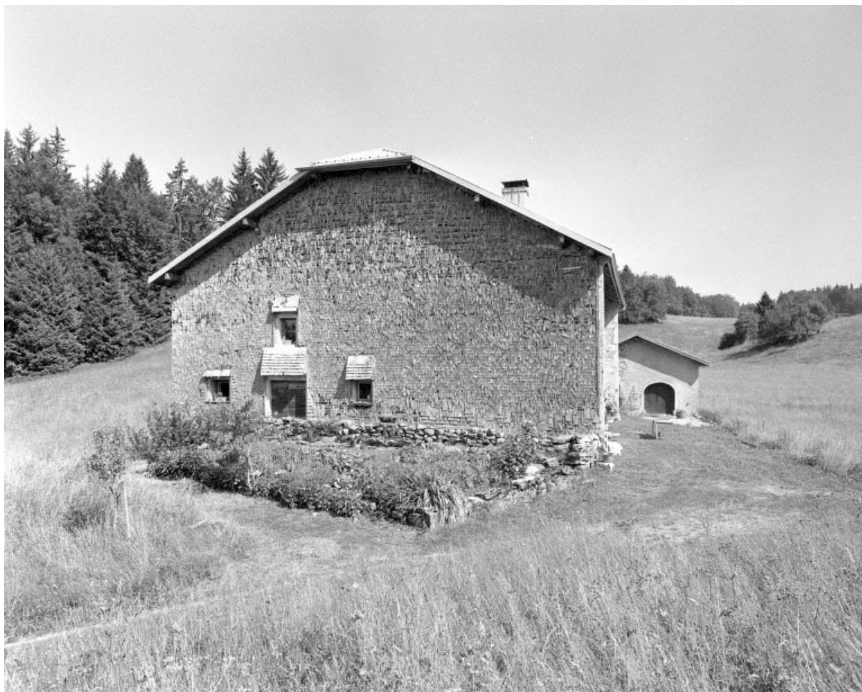
Face gauche recouverte d'un essentage de tavillons.
