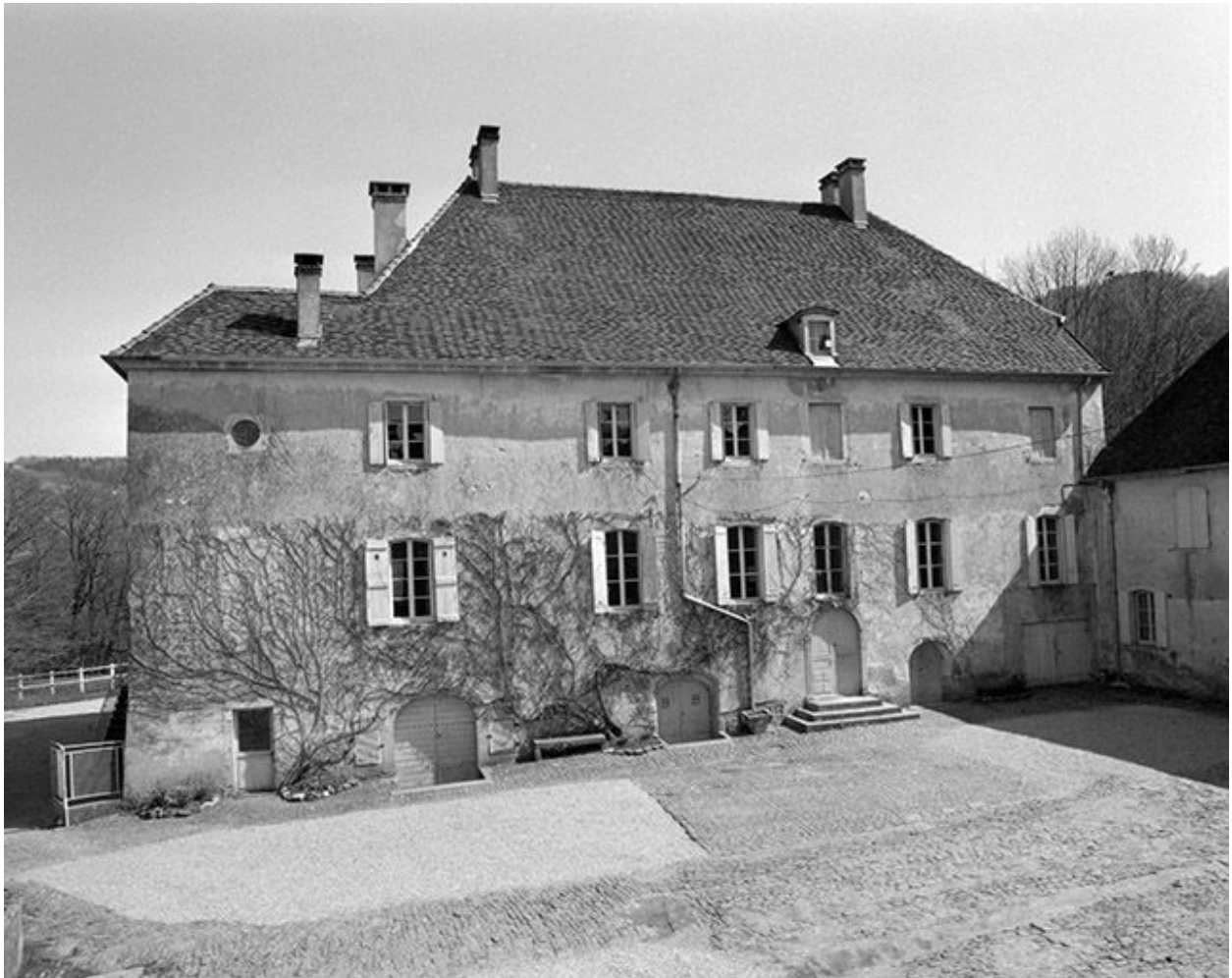
Logis : façade sur la cour.
