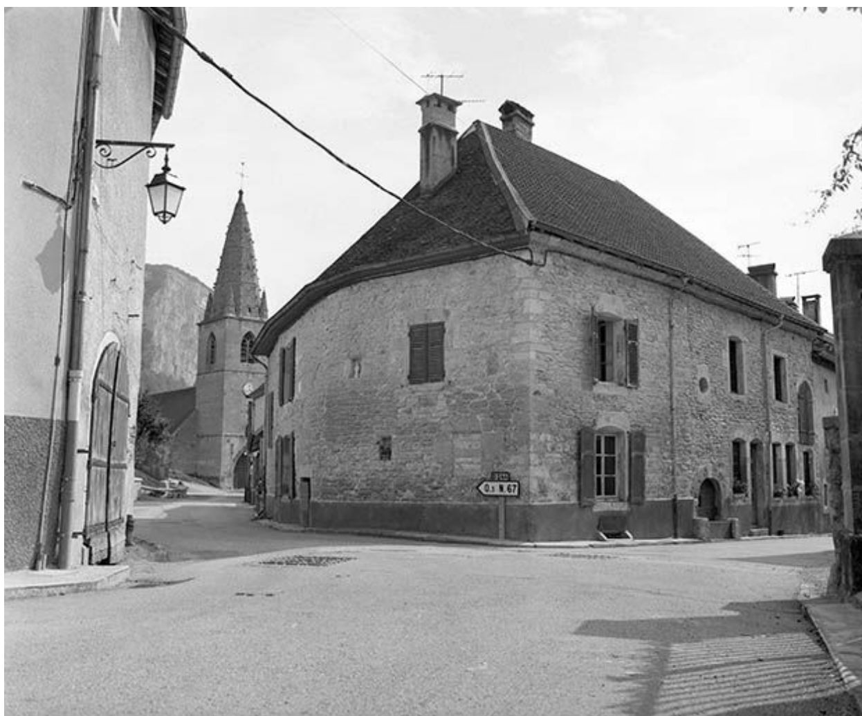
Maison située 3 rue Pavée.
