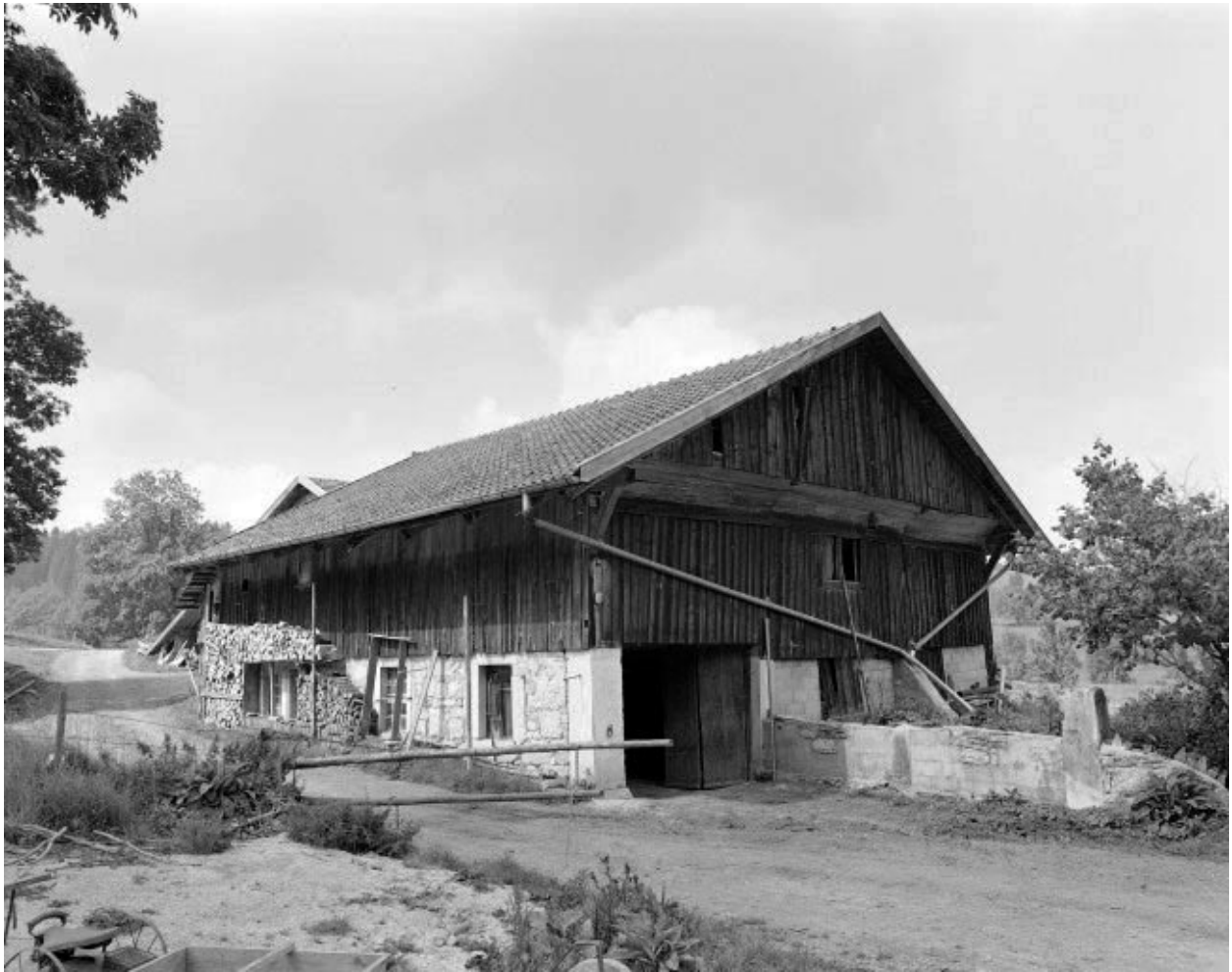
Extérieur : bâtiment annexe.
