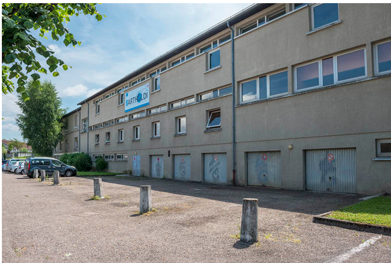
Façade nord rue de Bourdieu.
