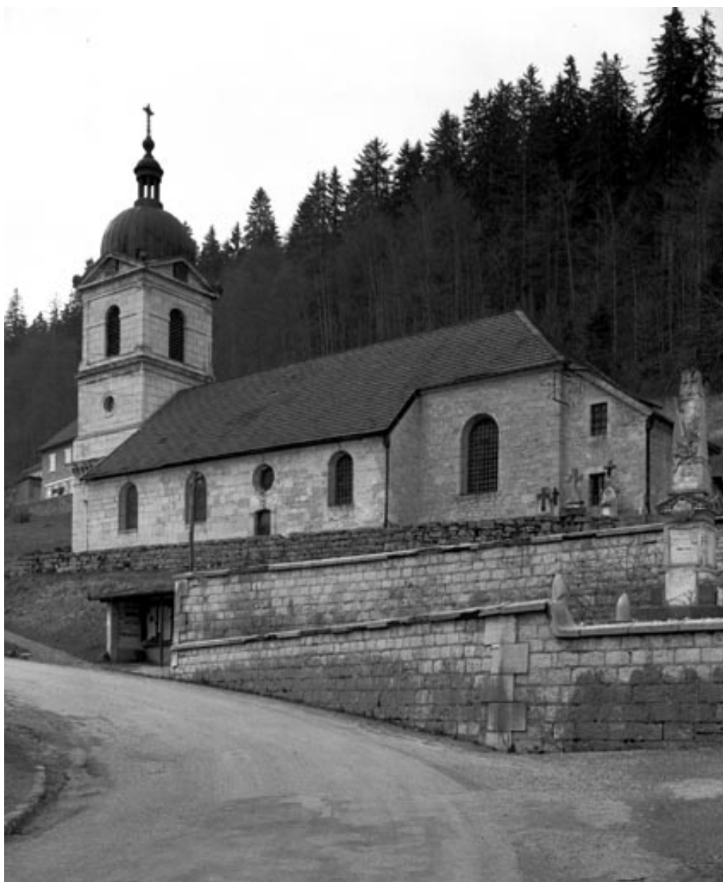
Façade latérale sud.
