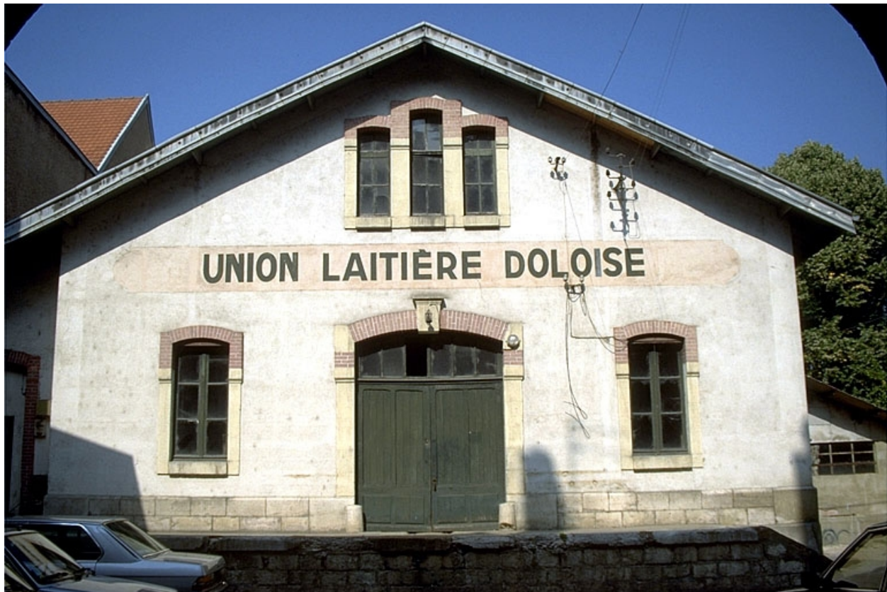
Façade antérieure de l'atelier de fabrication.
