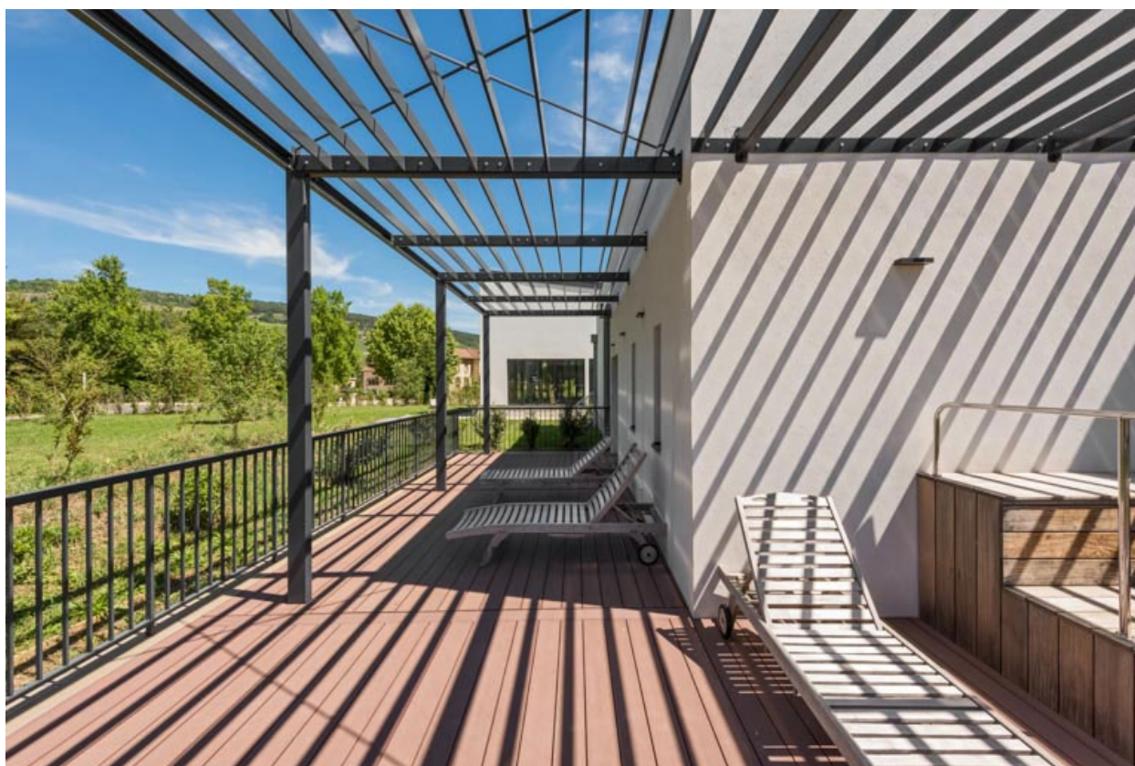
Centre thermal de 2021.
