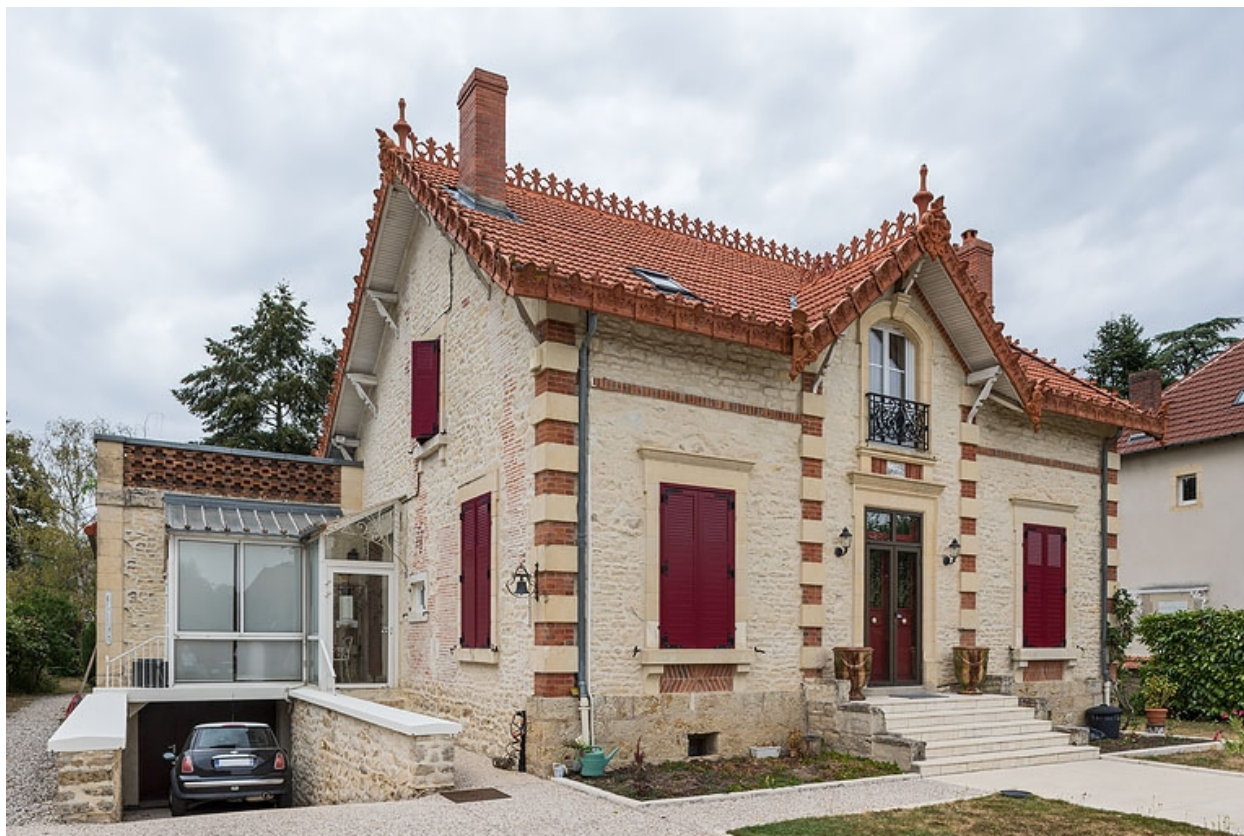
Façade principale, vue de trois quarts.
