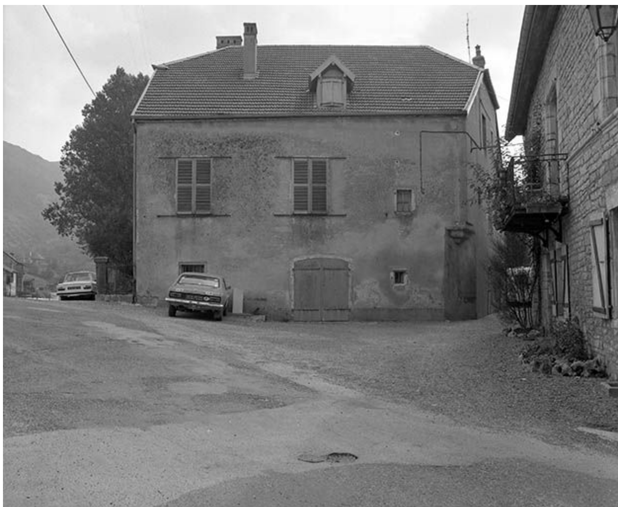
Façade latérale droite.
