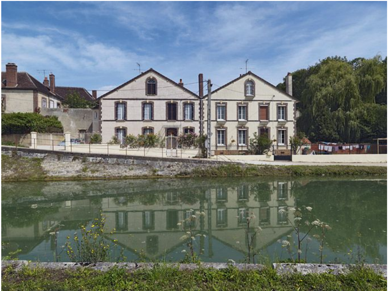
Amont du pont, rive droite : d'anciennes usines.
