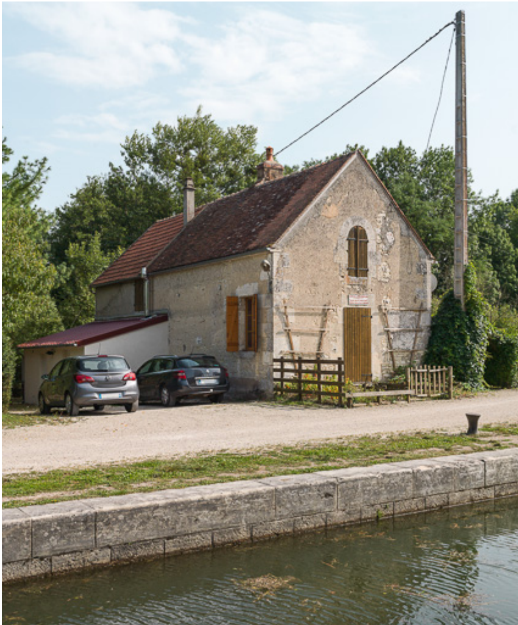
Vue de la maison éclusière.
