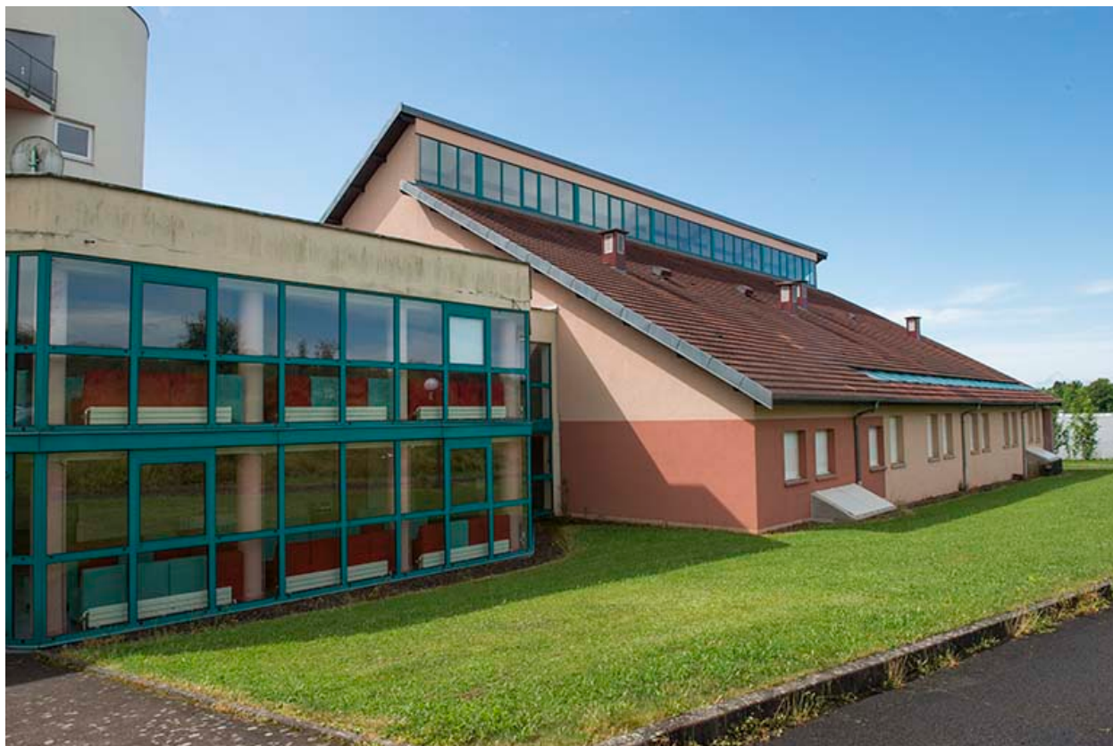
Façades postérieures nord de l'internat sud-ouest.
