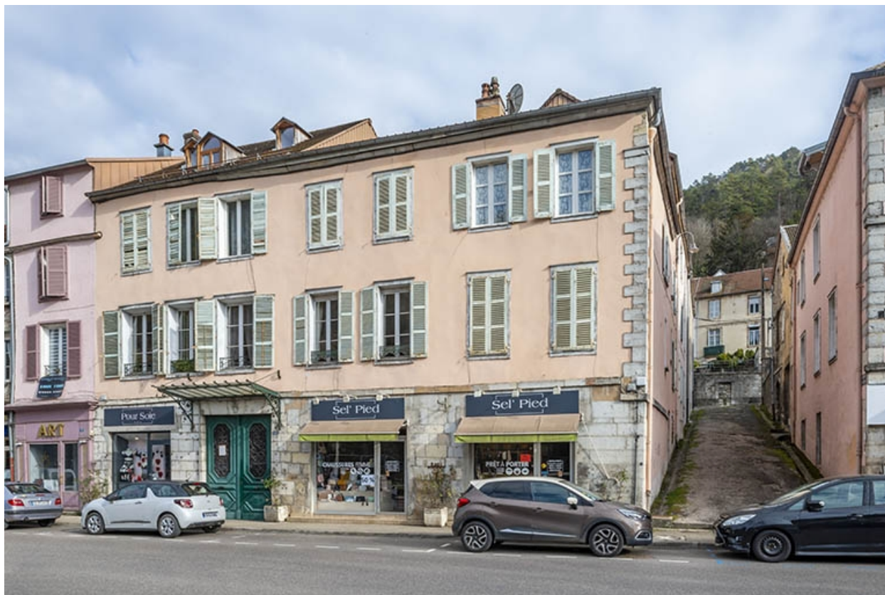
Façade sur la rue de la République.
