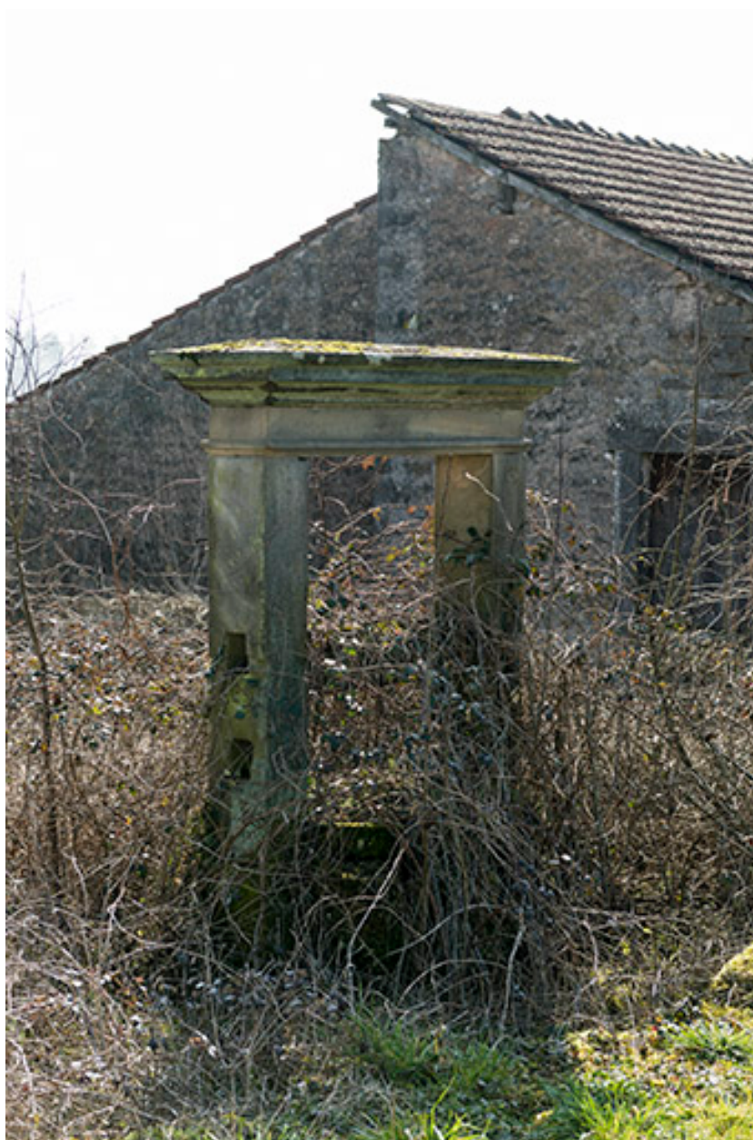
Ancien puits du bourg fortifié.
