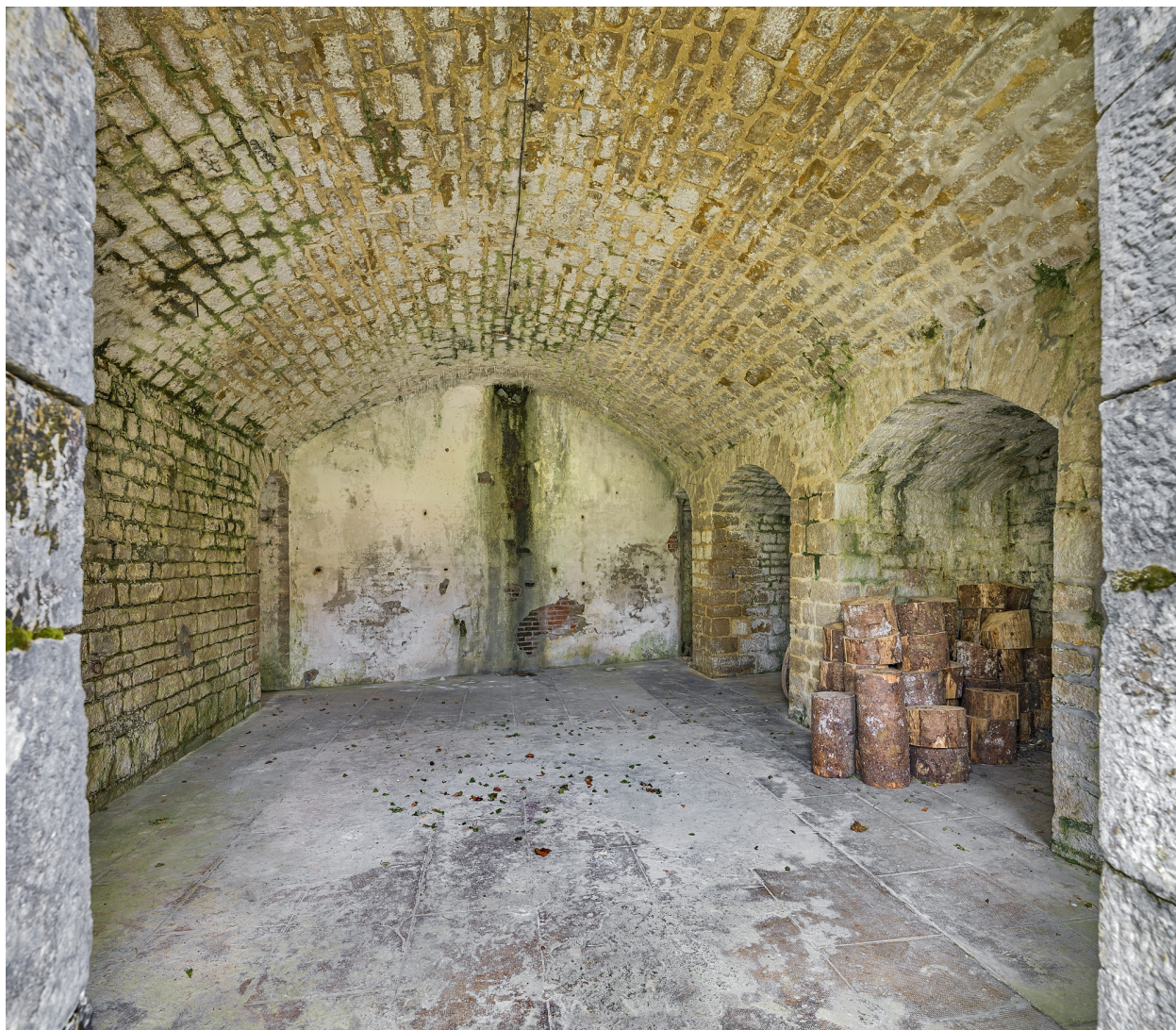
Salles casematées : détail et voûte.
