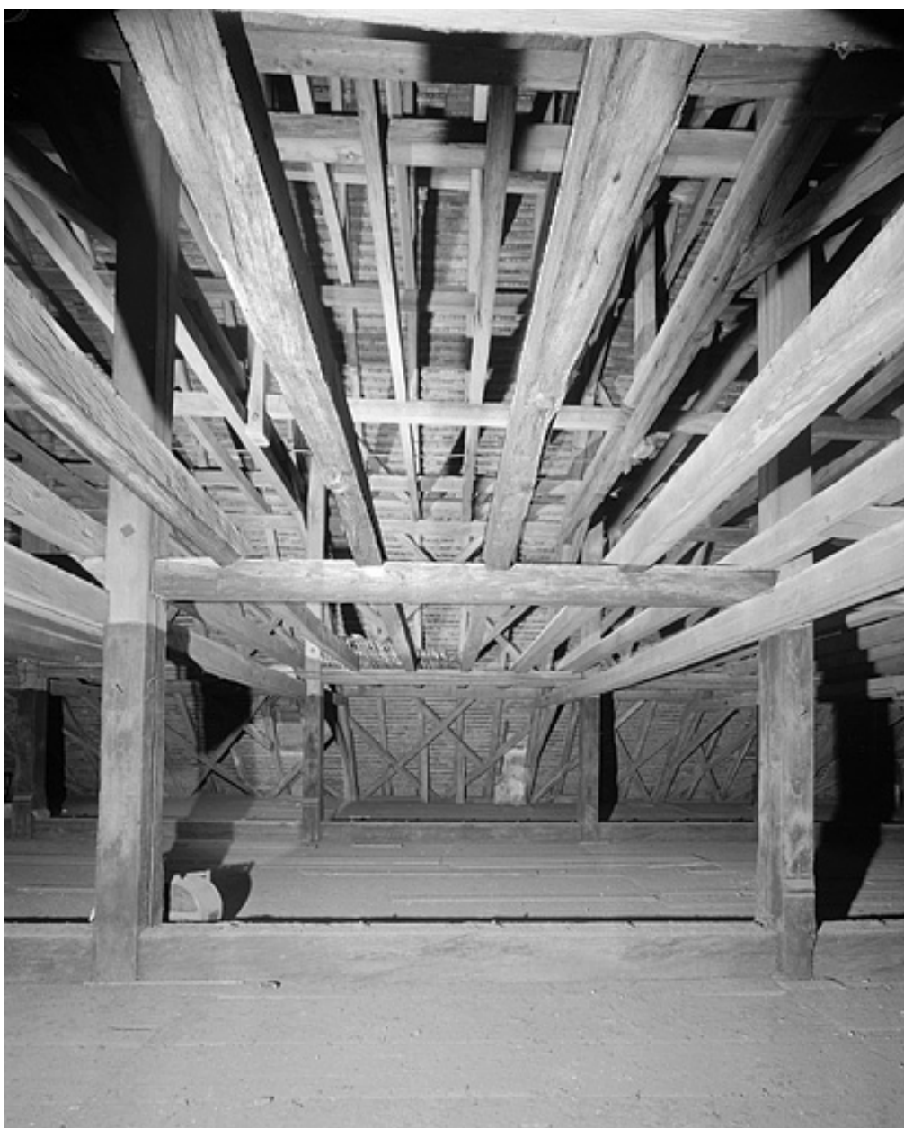
Charpente, vue latérale.
