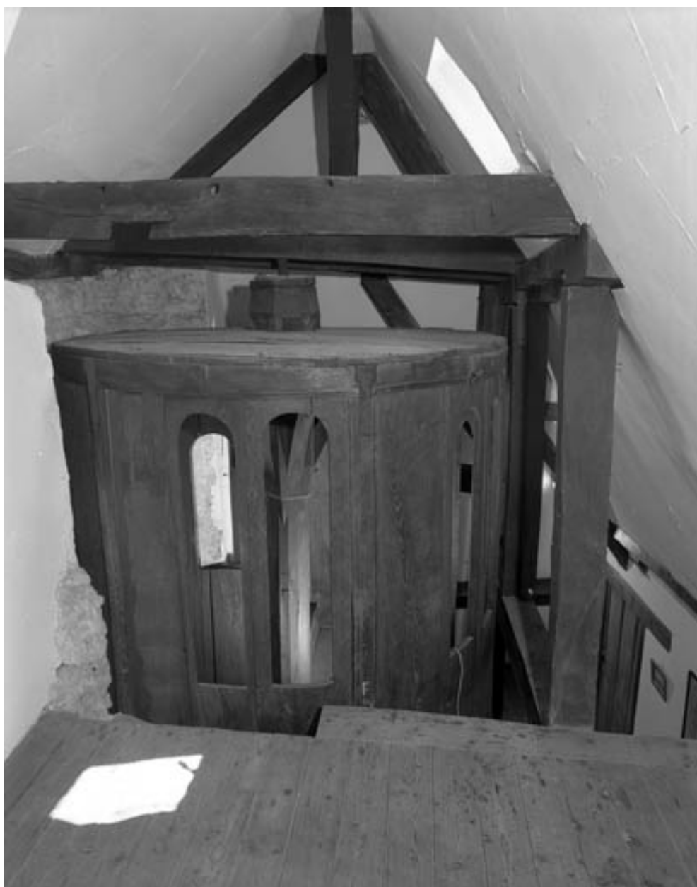
Sommet du cylindre depuis les combles.
