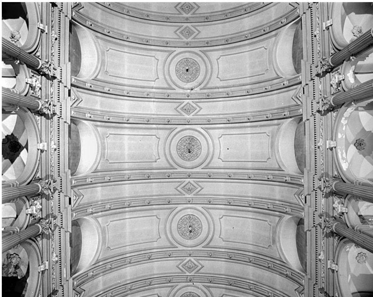
Fausse-voûte de la nef.
