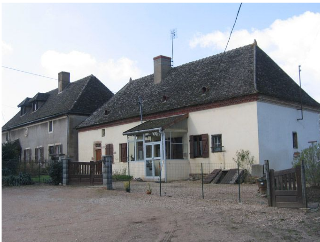
Vue d'ensemble de la façade.
