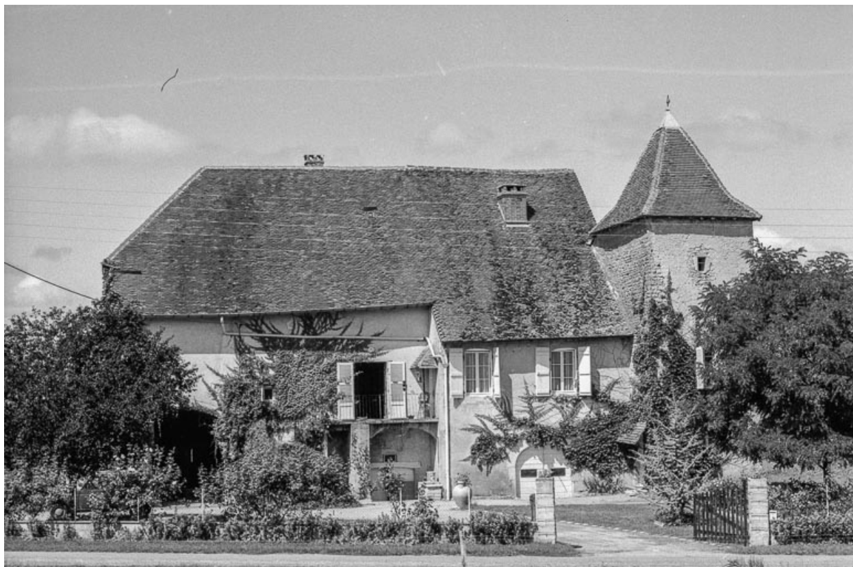
Maison : façade antérieure.
