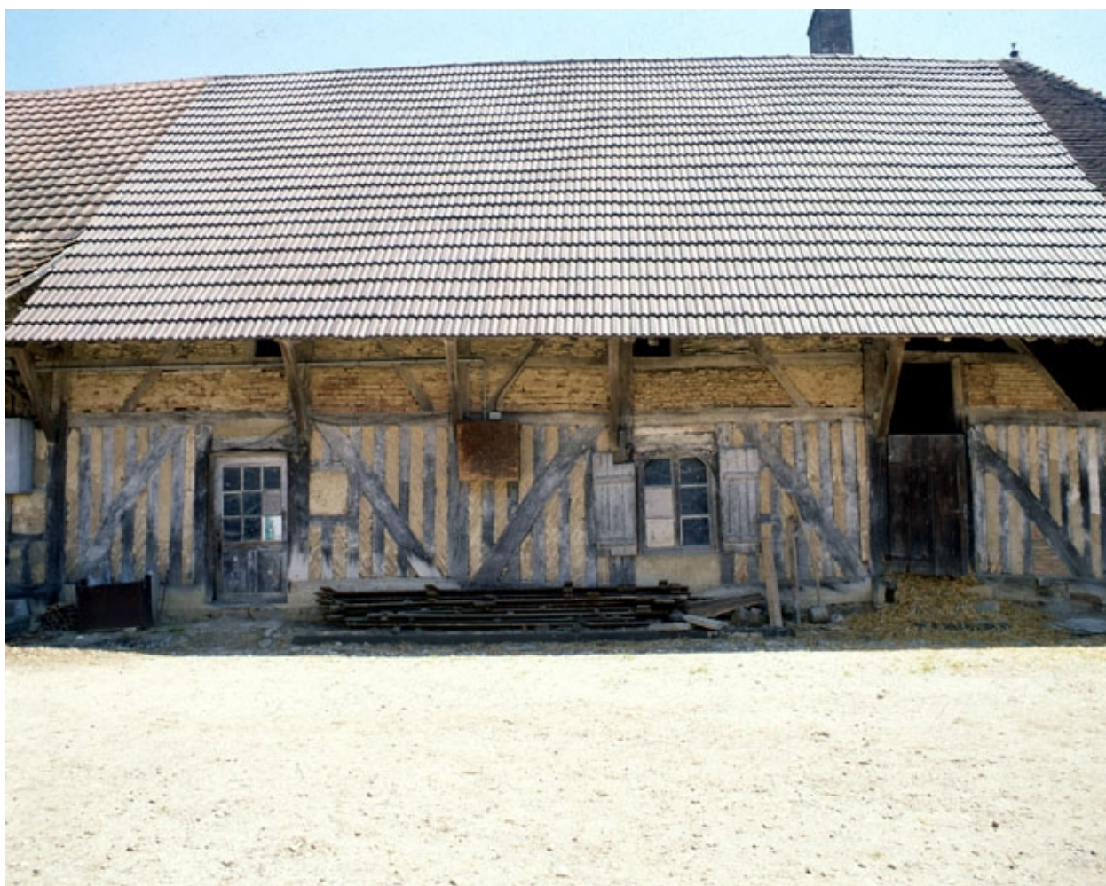
Bâtiment d'habitation : façade antérieure.
