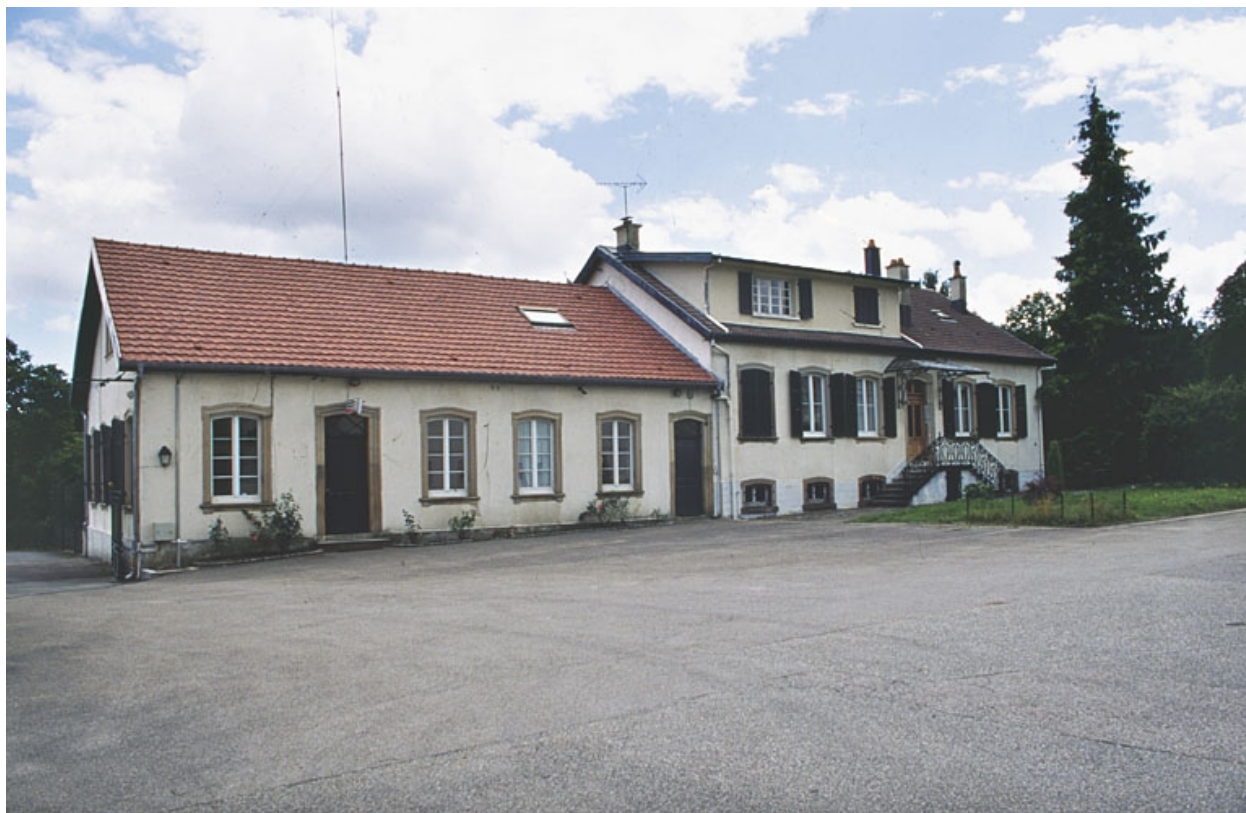
Les bureaux attenants au logement de contremaître.
