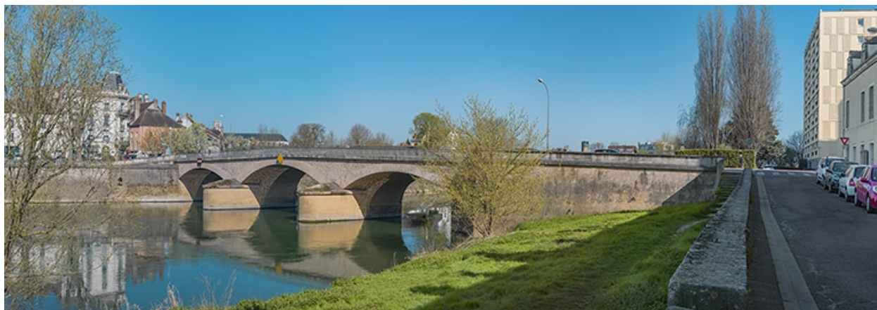
Vue d'ensemble, d'aval.
