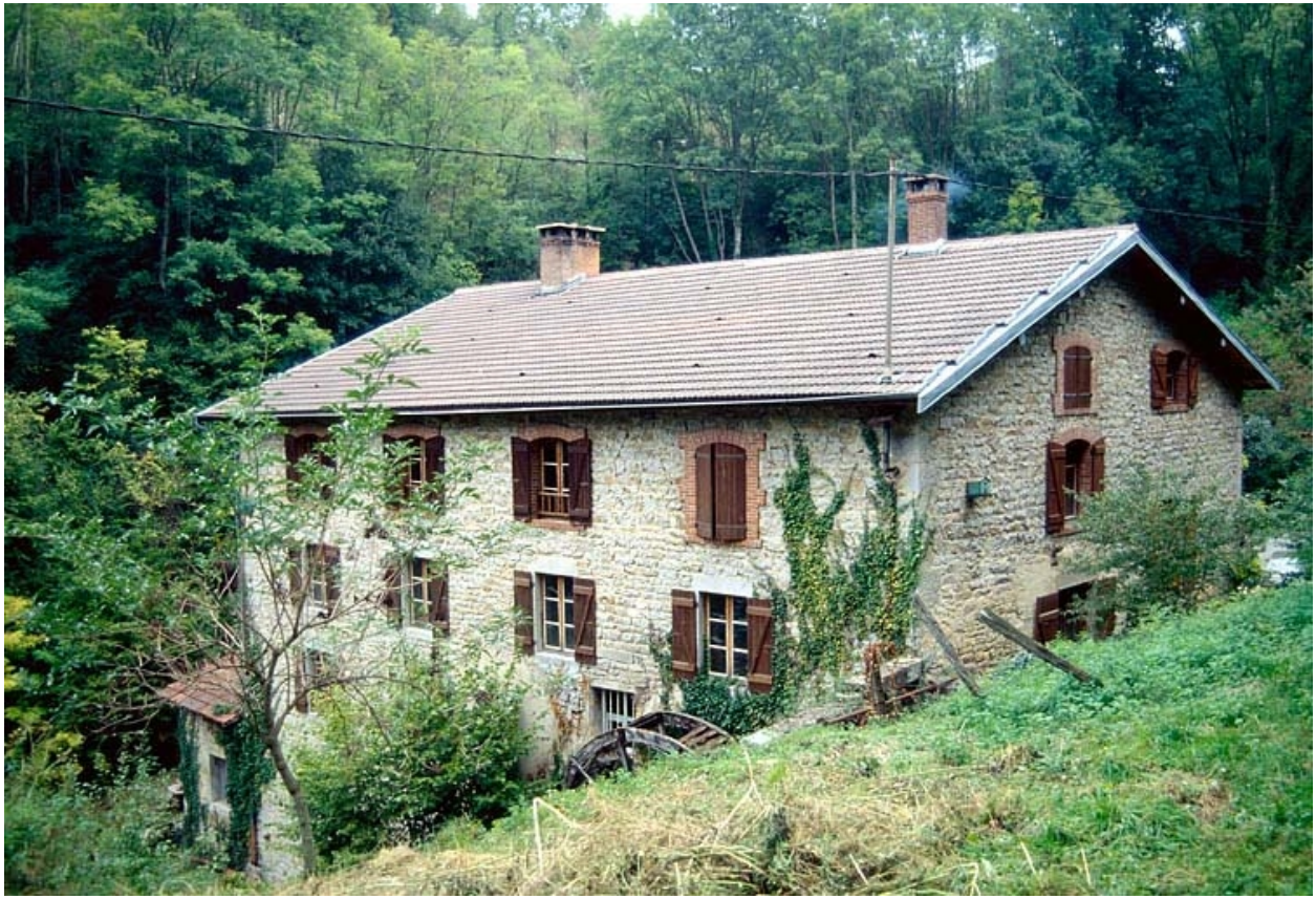
Façades postérieure et latérale gauche.
